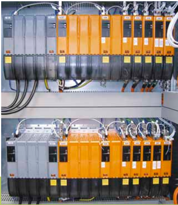
ACOPOSmulti Mehrachssysteme sparen Platz im Schaltschrank und reduzieren den Verkabelungsaufwand auf ein Minimum.
