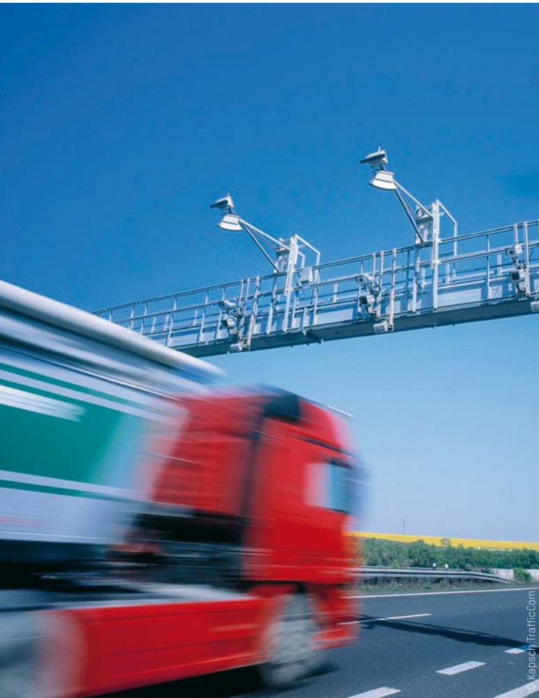
Über Mikrowellen-Antennen auf den Gantry genannten Gerüstbrücken hoch über der Straße werden zwischen den On-Board-Units im Fahrzeug und den Rechenzentren am Straßenrand Daten abgeglichen.
