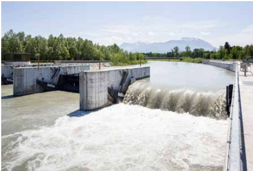
Die Kraftwerke der Stadtwerke Feldkirch versorgen sämtliche Feldkircher Haushalte mit Strom.
