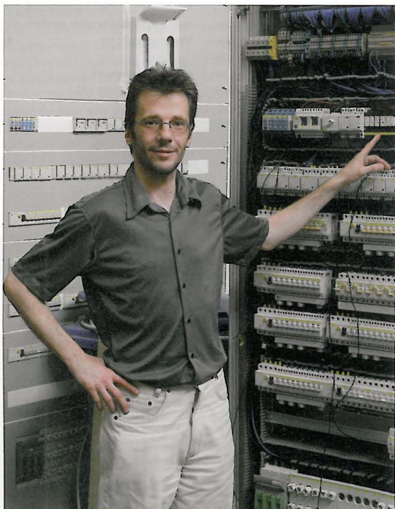
Ing. Theodor Christomannos, Leiter der Abteilung für Automatisierungstechnik, hier in der Csernohorszky-Elektrowerkstatt, ist mit Recht stolz auf das in kurzer Zeit umgesetzte Großprojekt.
