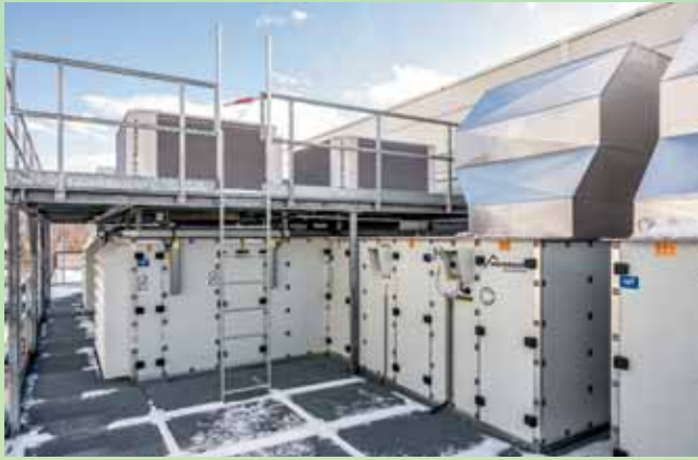
Die Hallenluft-Konditionierung dient im Sommer der Kühlung und verhindert gleichzeitig das Eindringen von Staub. Oben: die Kühleinheiten auf dem Dach
