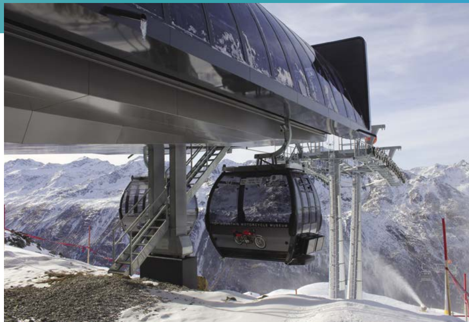
Die Beförderungsleistung der neuen D-Line übersteigt diejenige ihrer Vorgängeranlage von 1988 um ca. 50 Prozent. Zugleich sind die Stationsgebäude 20 Prozent kürzer und leichter zu warten.
