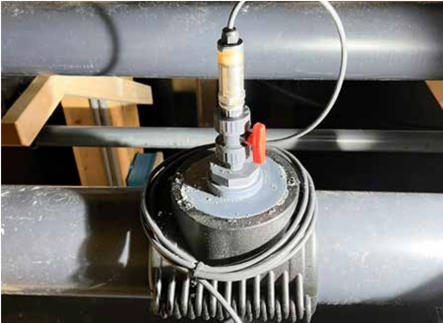
Der Cerabar PMP21 ist ein preiswerter Druckmessumformer mit Metallmesszelle für die Messung von Absolut- und Relativdruck in Gasen oder Flüssigkeiten.
