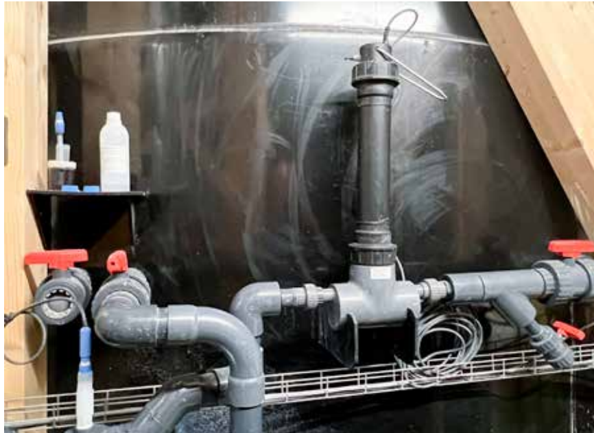
Der kontinuierlichen Online-Bestimmung von Nährstoffparametern wie Ammonium, Nitrat und weiteren Ionen dient der ionenselektive Sensor ISEmax CAS40D .
