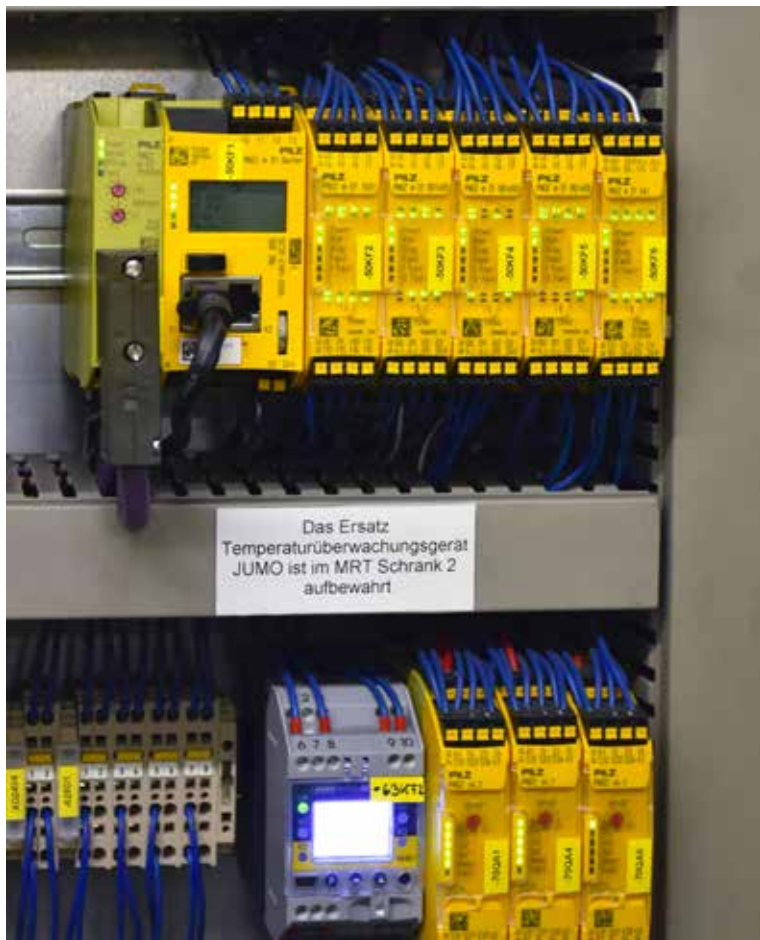
Pilz implementierte ein Brennermanagementsystem auf Basis der modular aufgebauten und bis zu SIL 3 und PL e TÜV-zertifizierten sicheren Kleinsteuerung PNOZmulti 2 Burner.
